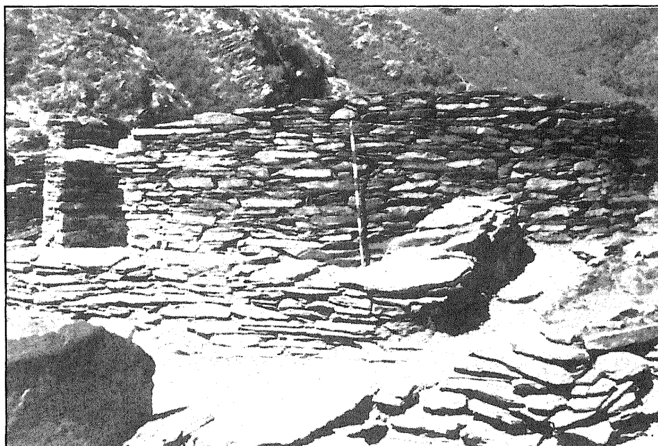
Vivienda CT9304: Lienzo exterior meridional después de extraer la "coza"
