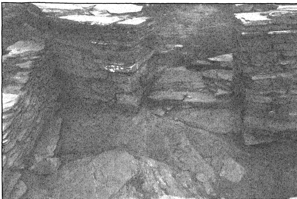
Vivienda CT9304: Detalle del vano de entrada
